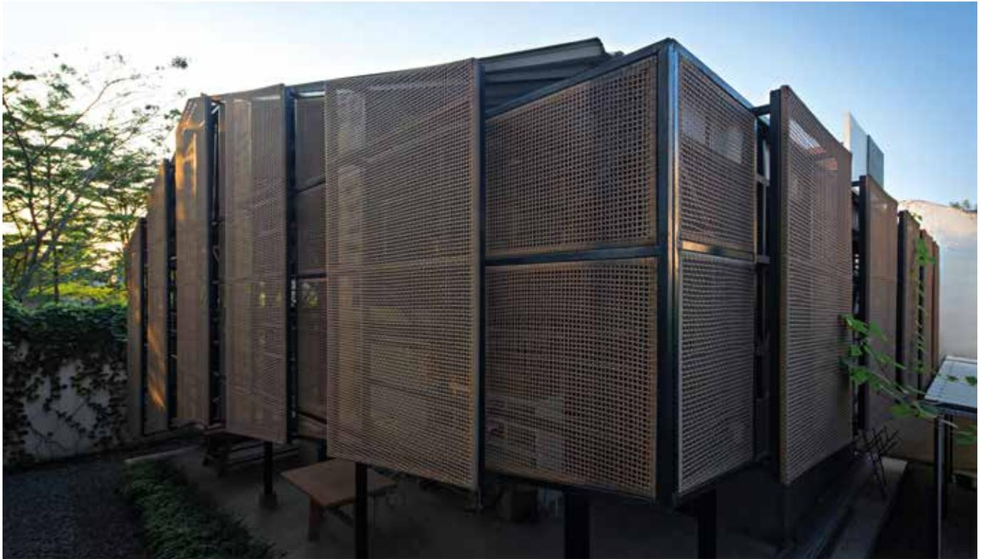
Fasad keseluruhan TSDS Maker Space yang tersusun dari modul rotan sintesis fabrikasi
