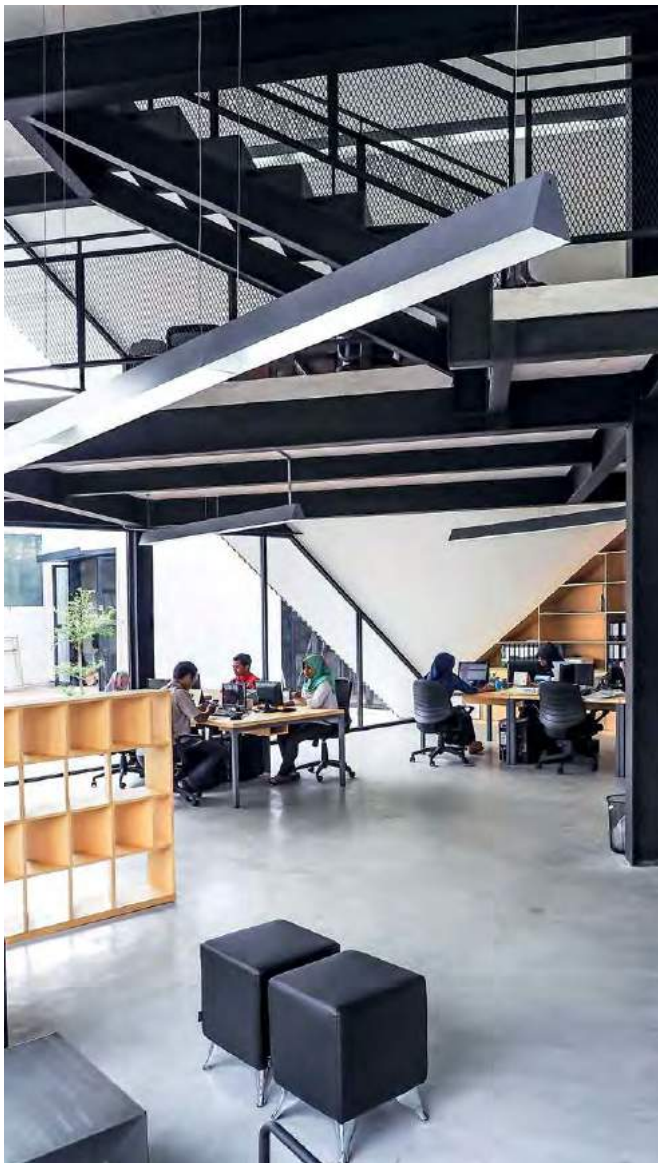
Baja menjadi struktur utama Office KL
