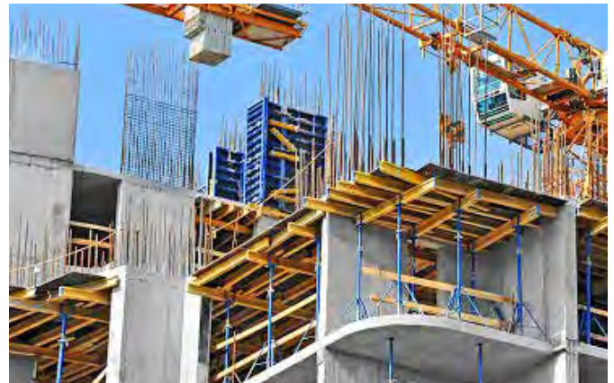
Ilustrasi pengecoran konstruksi bangunan
